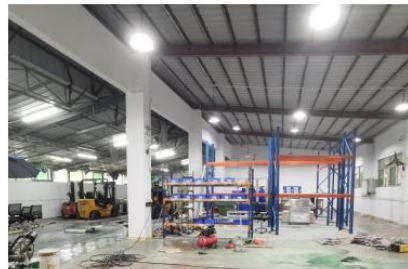
图 4: 改造施工过程
