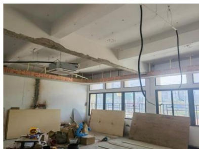
图 2 物流仿真实训室建设照片
